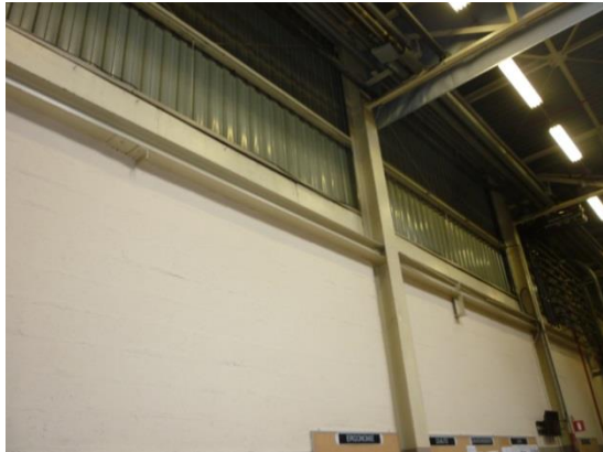
Figure 37 : Mur séparant le bâtiment A et le bâtiment cantine.
